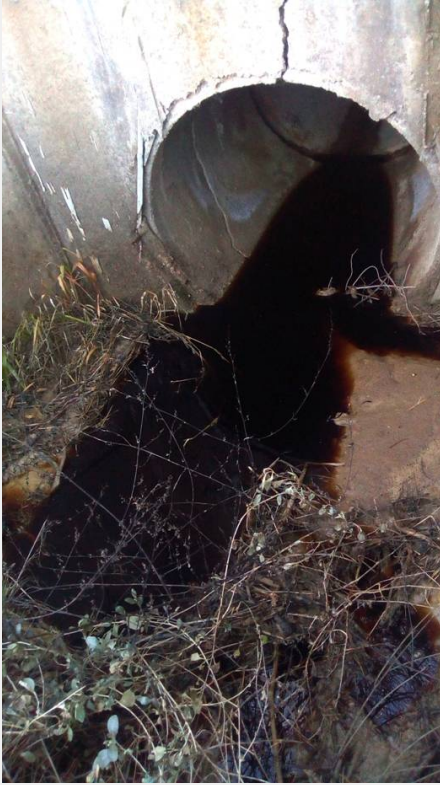
Έξοδος αγωγού ομβρίων
